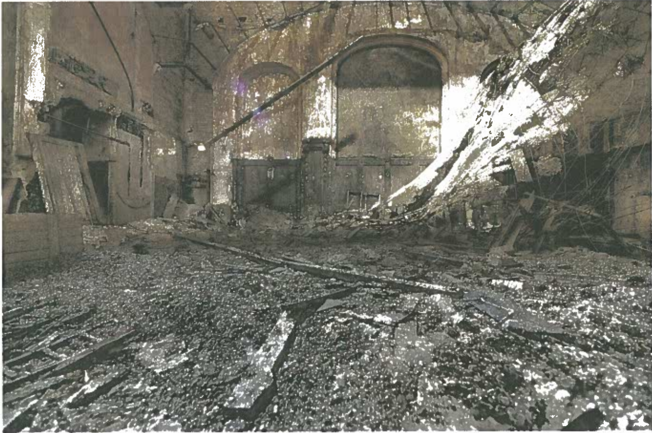
Ruine Die Gewölbedecke eingestürzt, dazu Schutt aus Jahrzehnten: So sah der Varietésaal aus, als Dirk Moritz ihn entdeckte
